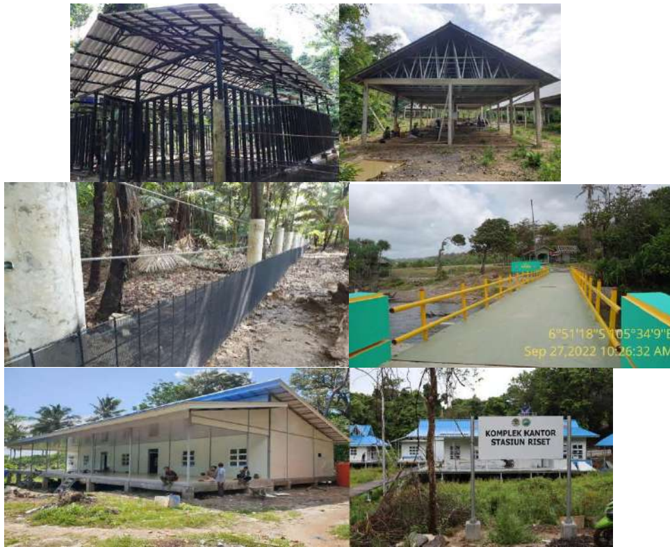
Gambar. Bangunan Paket Pekerjaan Sumber Dana SBSN
